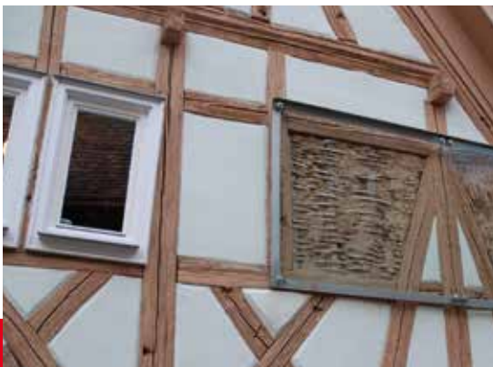
Gefach mit unverputztem Fachwerk in der Pfarrstraße
