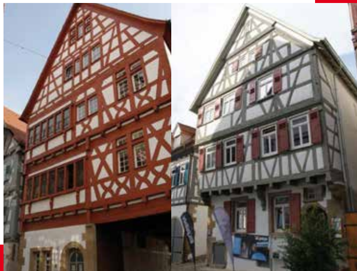
Fachwerk in der Schieringerstraße
