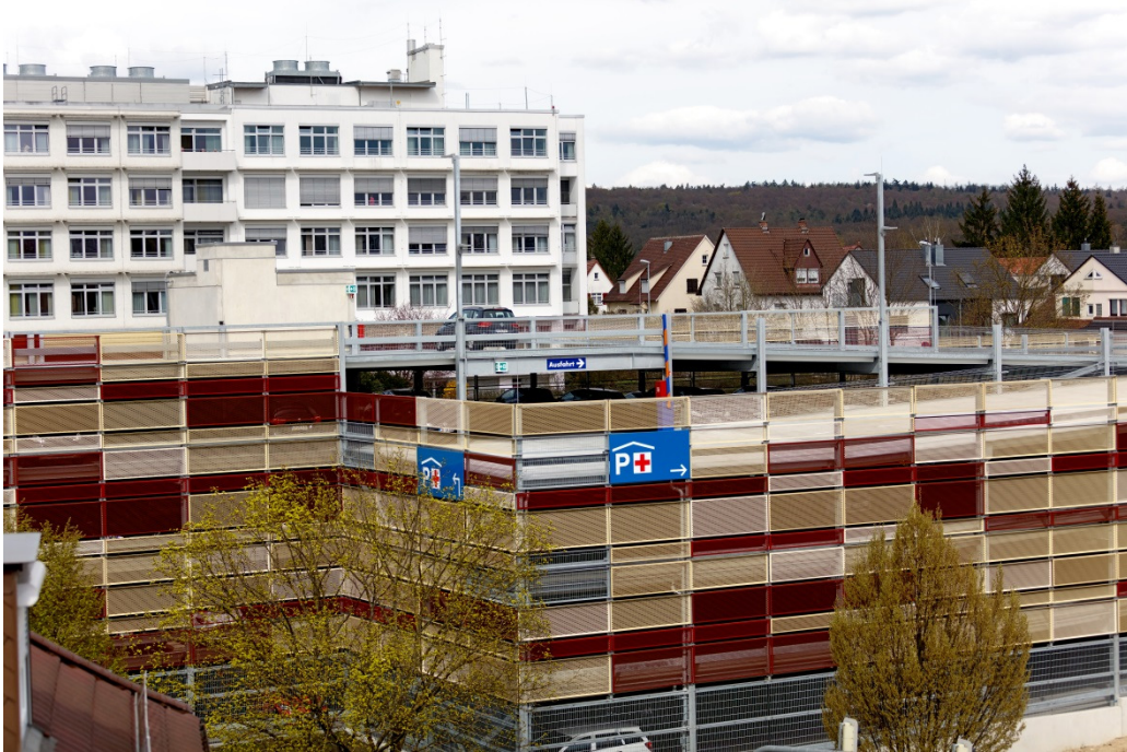
Bild: Parkhaus Krankenhaus
