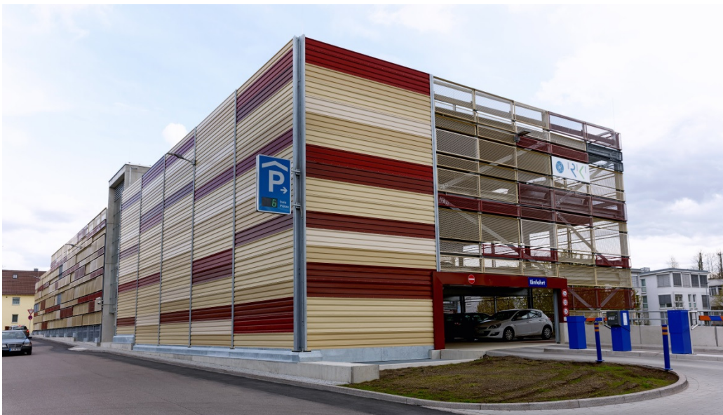
Bild: Parkhaus Krankenhaus
