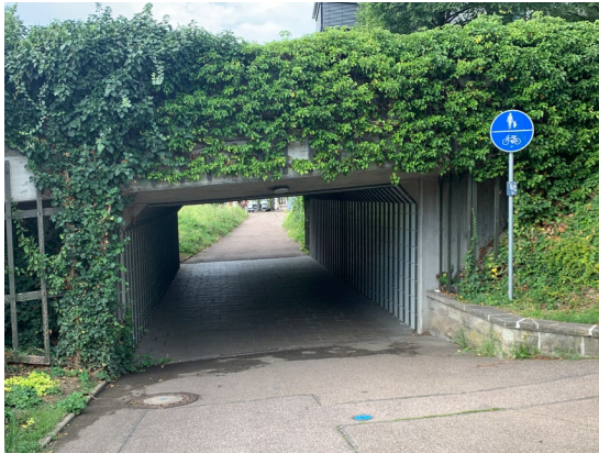
Foto 29: Besigheimer Straße – Unterführung
