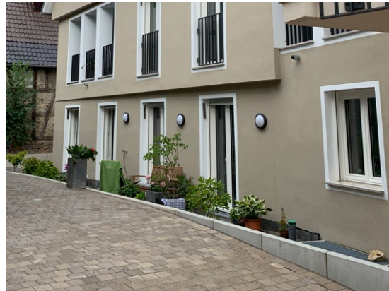
Foto 22: Kirchplatz – Wohnnutzung im EG
