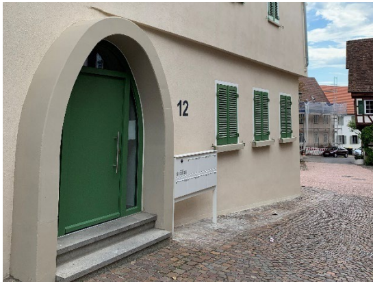
Foto 21: Kirchplatz – Wohnnutzung im EG
