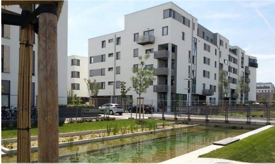
Bebauung am langen Anger (solar-professionell.de, © Passivhaus Institut)
