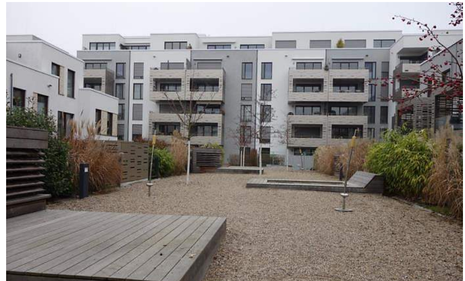
Innenhof (eigene Aufnahme, © Stadtentwicklungsamt)
