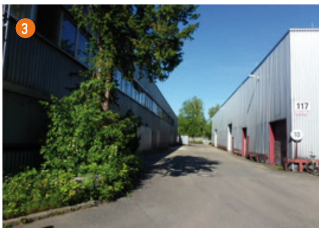
Durchfahrt zum hintern Bereich, Blickrichtung Bahndamm
