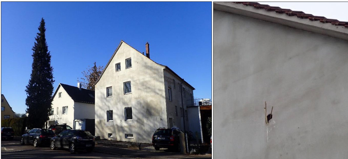
Abbildung 7: Wohnhäuser in der Freiburger Straße 7 (linkes Bild, links) und in der Rohräckerstraße 1 (linkes Bild, rechts) sowie ein aktueller Nistnachweis durch Kotspuren und Nistmaterial an der Rohräckerstraße 1 (rechtes Bild)
