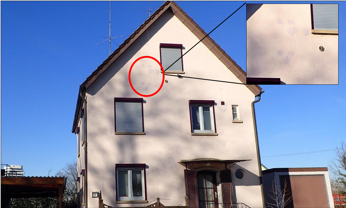
Abbildung 9: Wohnhaus in der Rohräckerstraße 3 mit verschlossenen Öffnungen in der Außenfassade
