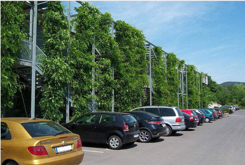
Parkhaus mit Fassadenbegrünung
